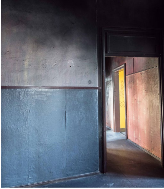
Zentralflur im 1. Obergeschoss
